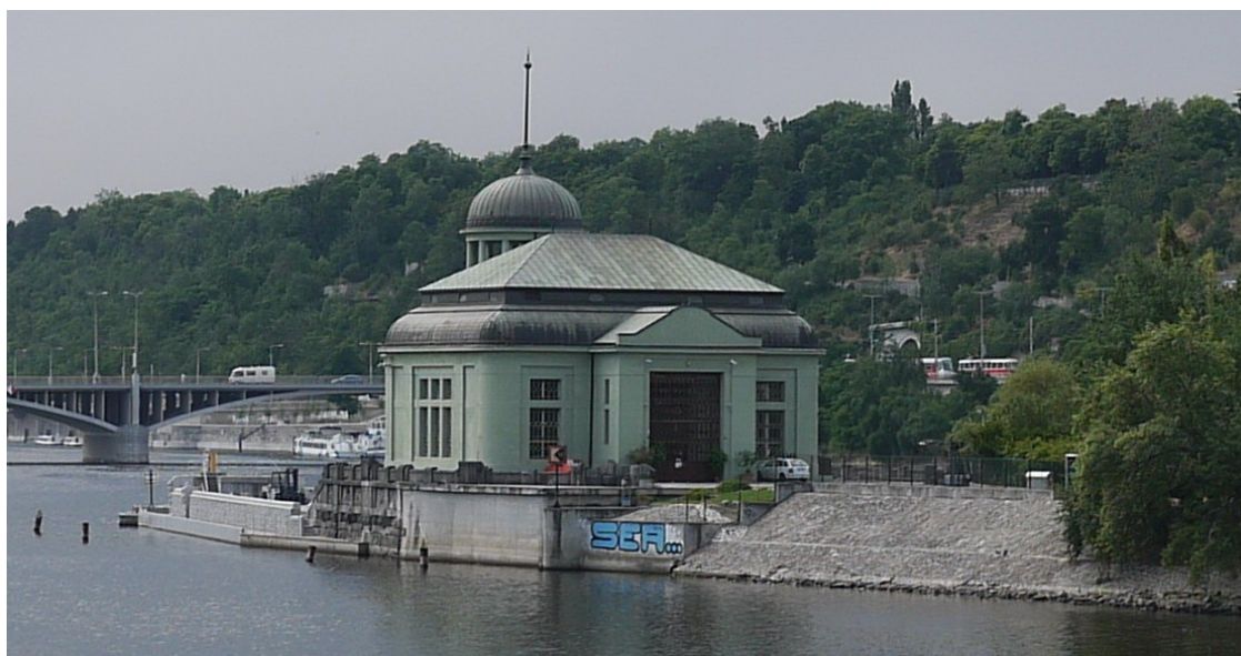
Obr. 2: Vodní elektrárna na Štvanici
