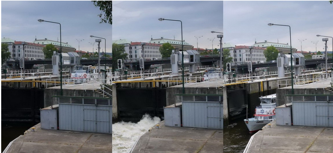
Obr. 6: Postupné klesání vody v plavební komoře
