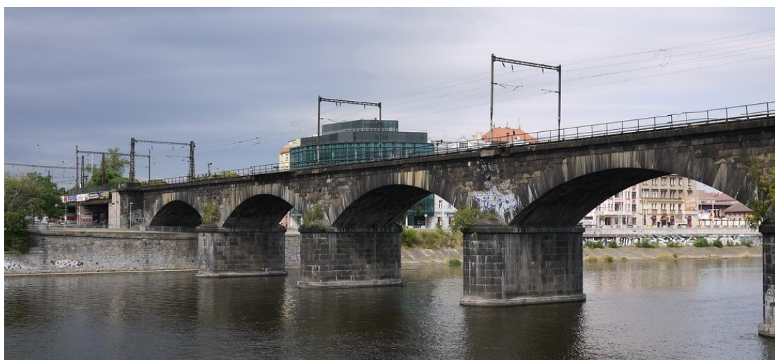
Obr. 5: Část Negrelliho viaduktu
